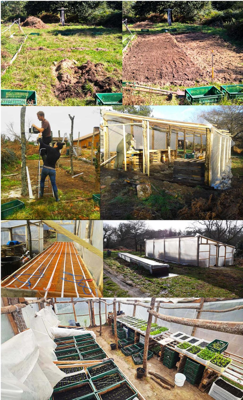
**Figure 9 :** Construction de la serre pépinière de 5m x 10m avec bâches d'occasion et une grosse partie du bois et des palettes récupérés.
